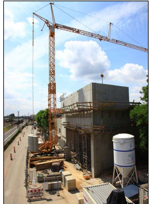
Baustelle des Vollsortimenters im Juli 2010
