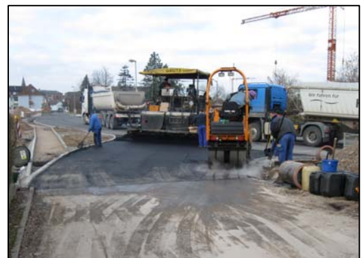
Fertigstellung des letzten Straßenanschlussstücks im „Bruchhäuser Weg“
